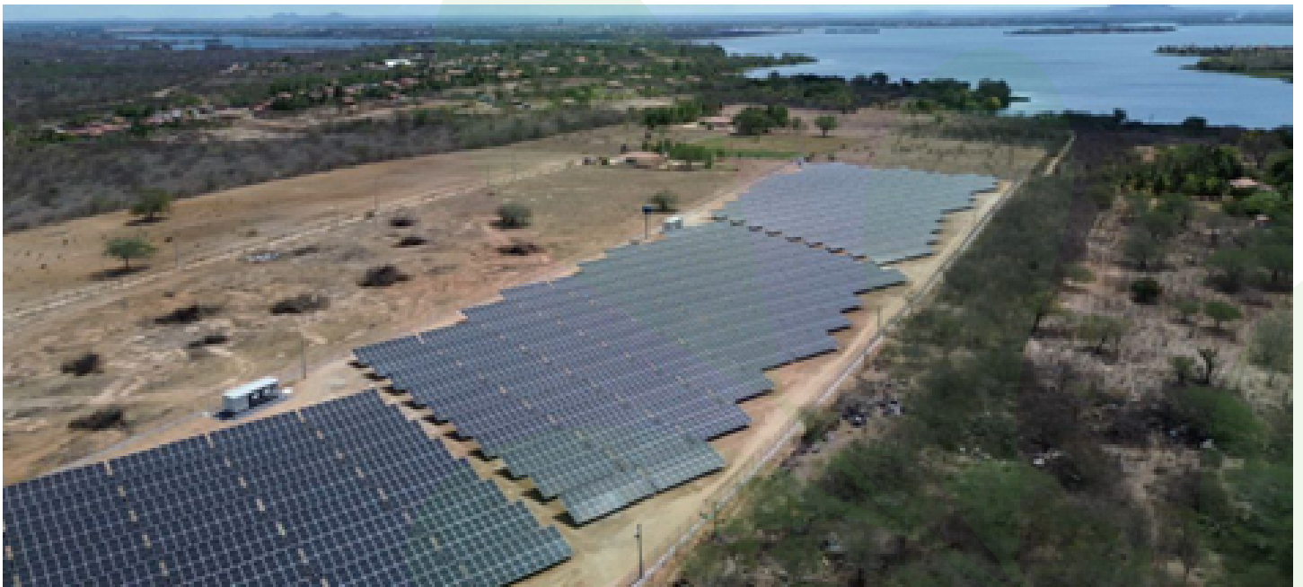
Figura 3 - Usina conta com 6 mil placas solares e capacidade para gerar até 5,7 megawatts-hora por ano. Foto: Maykon Farias - TV Tribunal.
